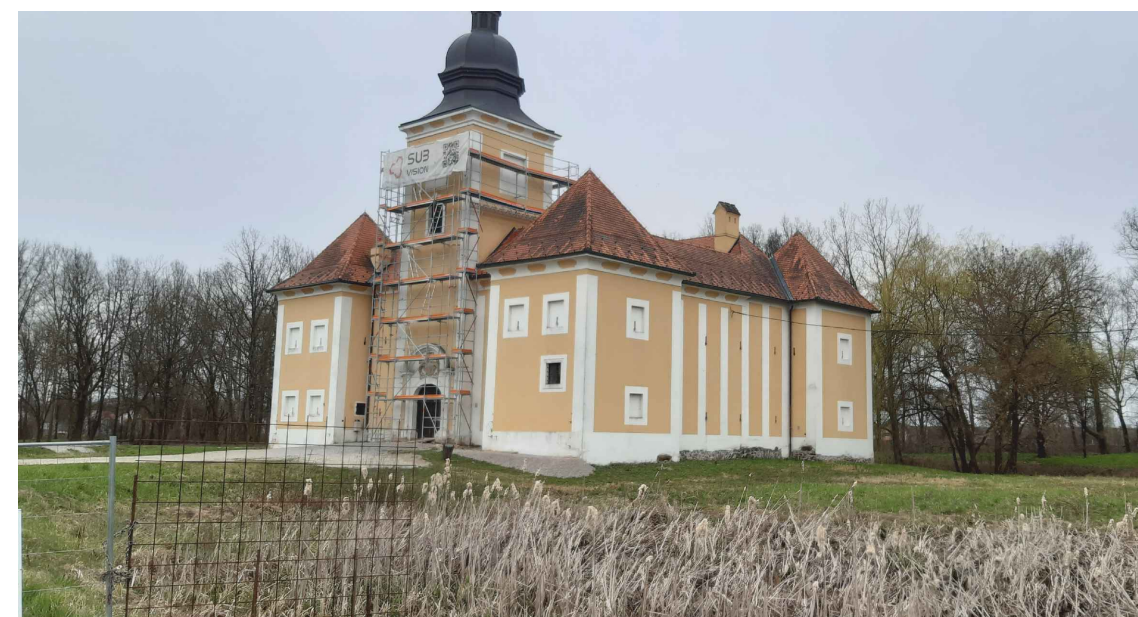
Stari grad Lukavec u fazi izvođenja sanacije i ojačanja konstrukcije_ožujak 2023.
